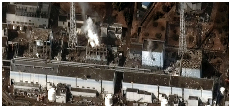
Abbildung: Satellitenfoto der Reaktorblöcke 1 bis 4 am 16. März 2011 nach mehreren Explosionen und Bränden
